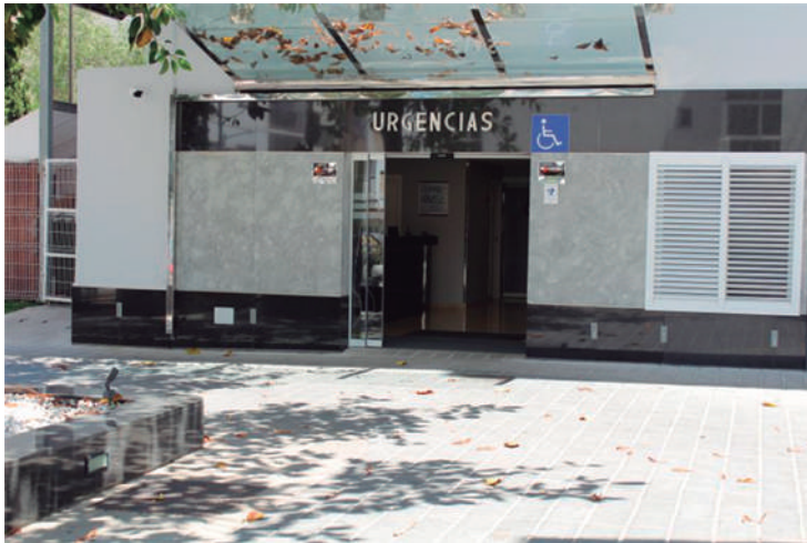
Acceso Accesible URGENCIAS
